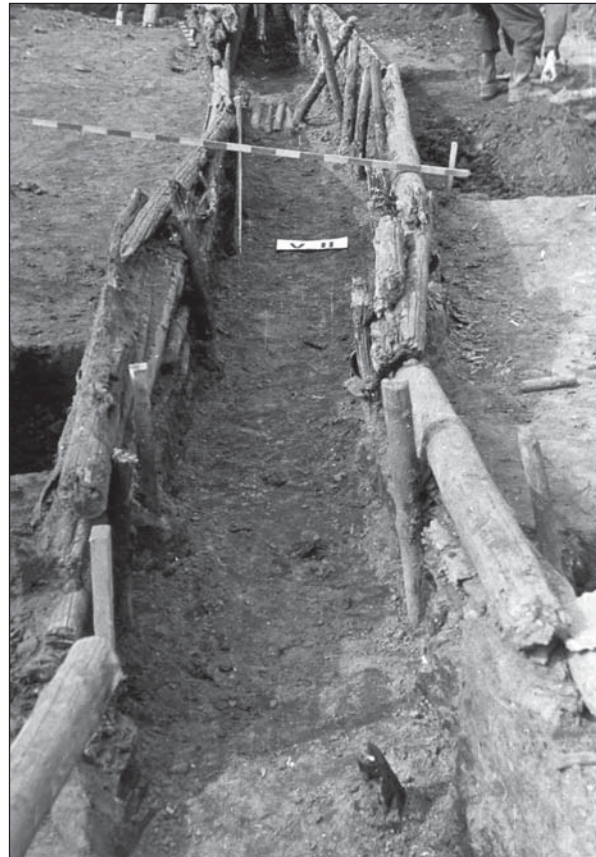
Дренажный канал XV в., огражденный плетнями и укрепленный бревнами. Раскопки 1951 г.
