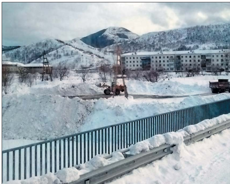
Работы по складированию снега с территории Горнозаводска в русло р.Лопатинки. 11 марта 2018 г.
